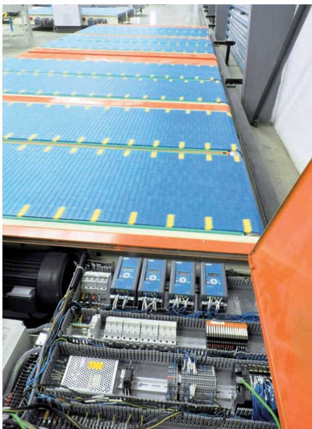
Automatický preberací vozík má pohyb svojich dopravníkových pásov tiež riadený frekvenčnými meničmi Danfoss Vacon 20.
