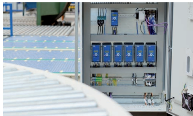
Celkovo 75 frekvenčných meničov Danfoss Vacon 20 zabezpečuje plynulý chod dopravníkov za technologickými zariadeniami.
