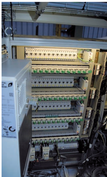
Inteligentný prepojovací a komunikačný systém Eaton SmartWire-DT ušetril pri výrobe oboch rozvážačov pre obe vŕtacie vozidlá približne 80 pracovných hodín.
