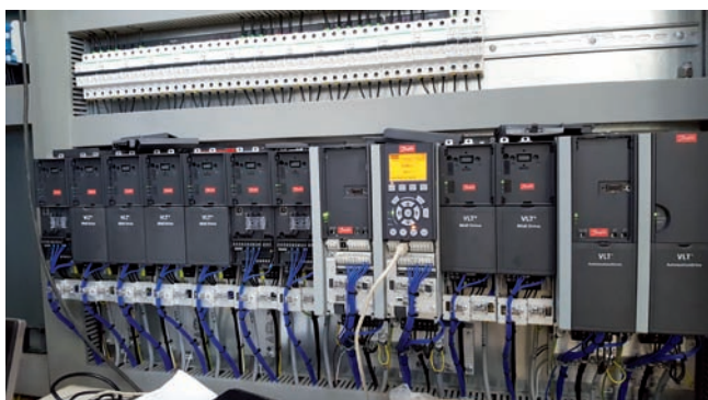
Obr. 1 Umiestnenie meničov VLT® Midi Drive FC 280, VLT® AutomationDrive FC 302 v rozvádzači
