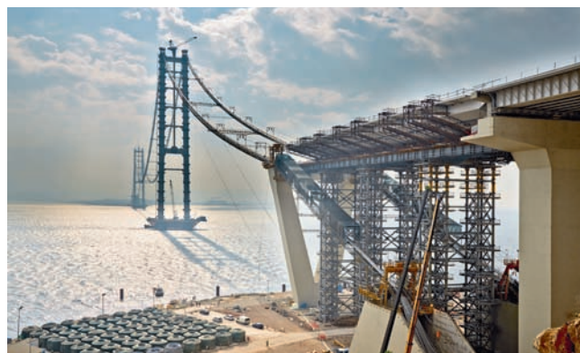
Obr. 6 Pohľad zo severného konca stavby: montáž jednotlivých segmentov pred ukončením v priebehu niekoľkých týždňov.
