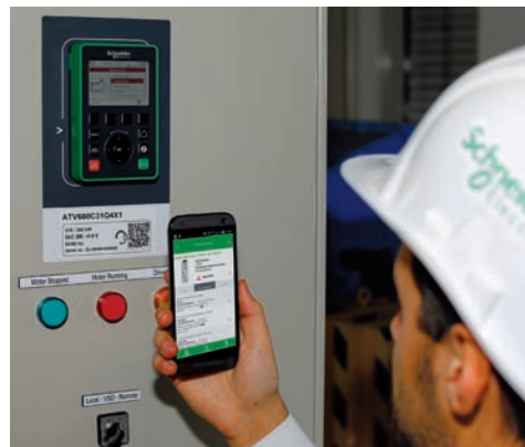
Statické a dynamicky generované QR kódy okamžite poskytnú potrebné informácie o frekvenčných meničoch Altivar.
