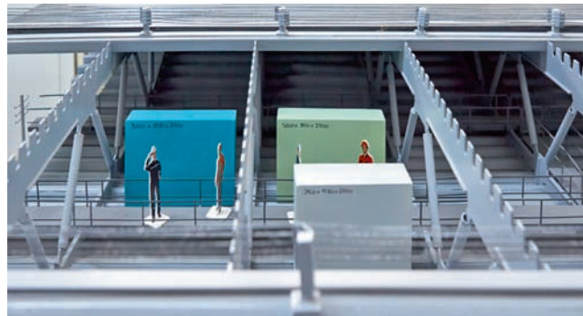
Obr. 5 Model sekcie s jedným poschodím segmentu: obslužná úroveň je umiestnená pod úrovňou vozovky, kde sú jednotlivé kontajner obsahujúce riadiace rozvádzače.
