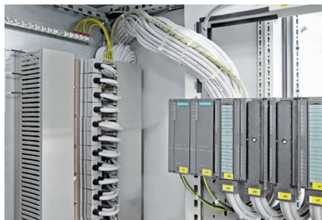
Obr. 2 Adaptéry z rodiny produktov VIP-Power Cabling ponúkajú 20 a 40 pripojovacích bodov na ľahké prepojenie V/V zostáv systémom pripoj a pracuj.
