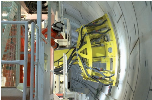
Vŕtacia súprava Crossrail pracuje v tuneli Temže, ktorý dosahuje dĺžku takmer 2 míle za mesto Londýn. Odolný rad axiálnych piestových čerpadiel Eaton dodáva olej hydraulickým systémom, ktoré manipulujú s ramenami a ovládajú 36 vŕtákov.
